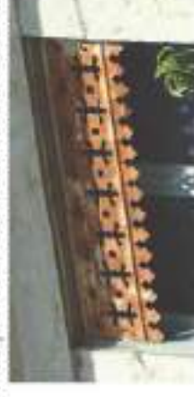
9. Masquer le caisson des volets-roulants
